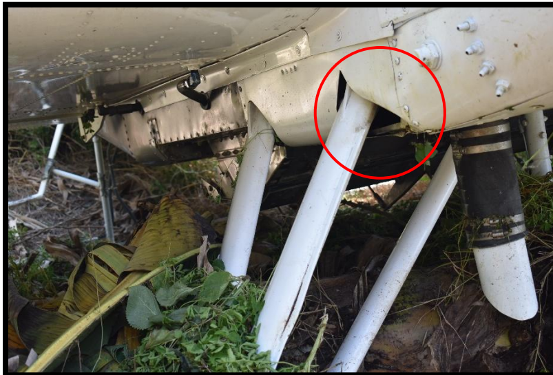
Fotografía No. 12 Golpes en cobertores del fuselaje lado derecho inferior.
